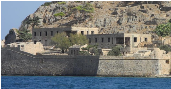
Εικ. 7. Ορέστης Μάλτος, μεσοπολεμικά κτήρια Λεπροκομείου, Σπιναλόγκα, Κρήτη.
