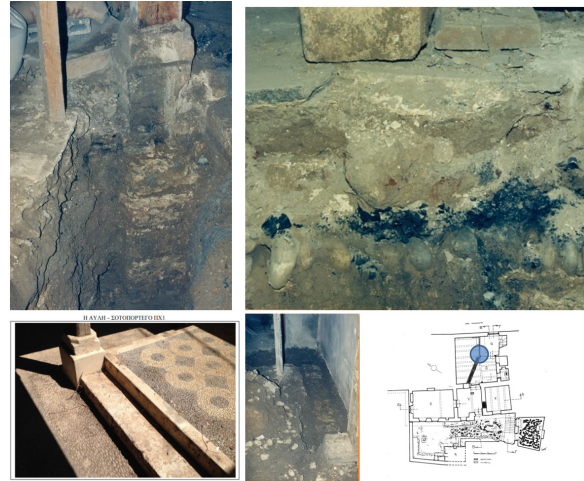
Εικ. 6. Ανατολική αυλή. Διερευνητικές τομές κατά τις εργασίες αποκατάστασης.
