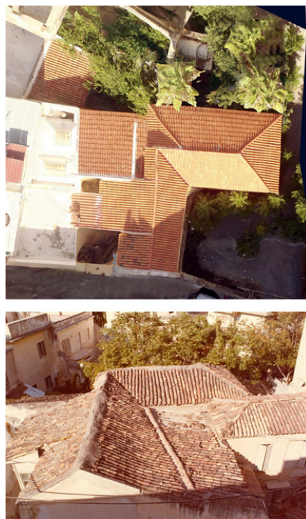
Εικ. 3. Στέγες πριν και μετά από την αποκατάσταση.
