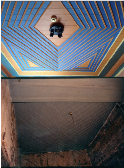
Εικ. 8. Όροφος, χώρος εισόδου: η οροφή πριν και μετά από την αποκατάσταση.
