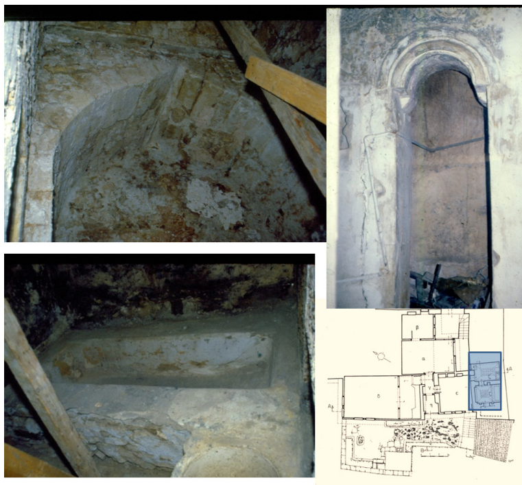
Εικ. 10. Όροφος, χαμάμ. Λεπτομέρειες του θερμού χώρου κατά τις εργασίες της αποκατάστασης.
