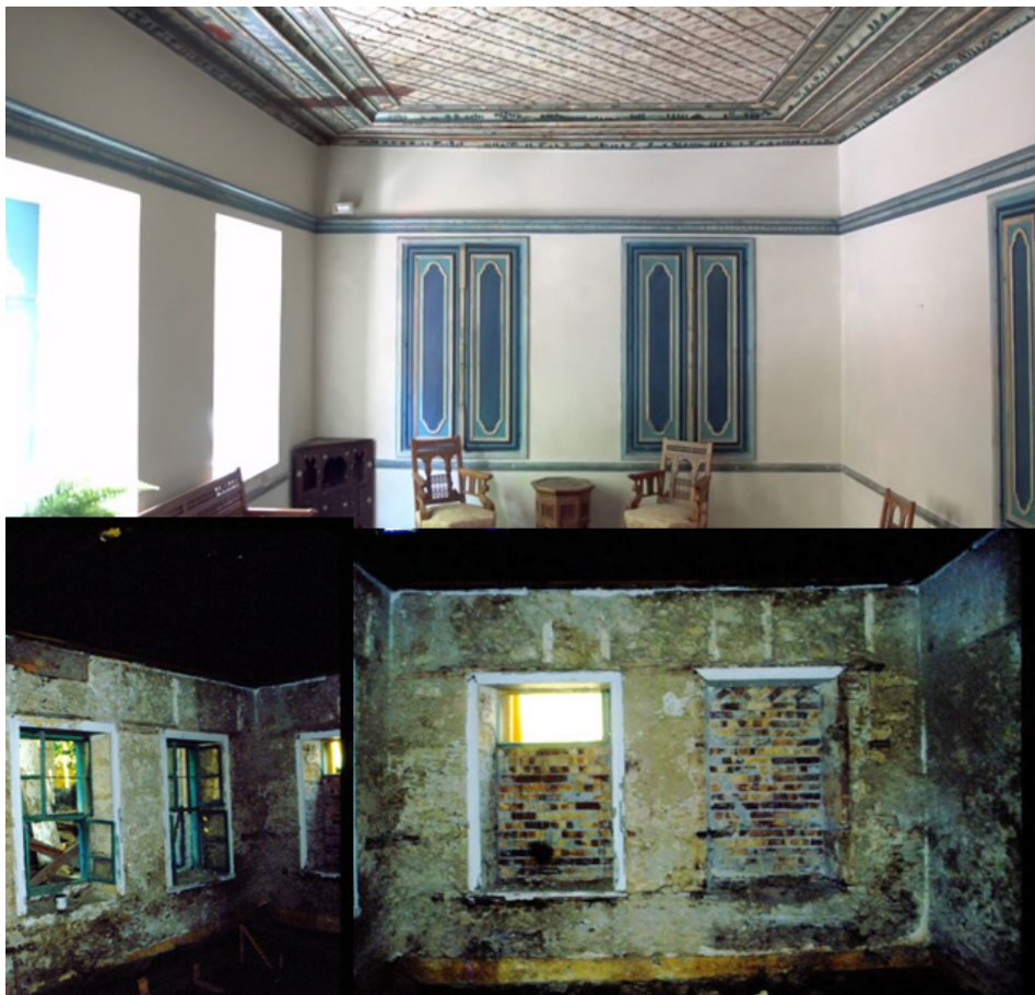
Εικ. 4. Άποψη του χαμηλού οντά πριν και μετά από την αποκατάσταση. Λήψη από νότο.
