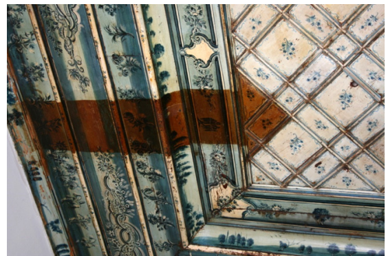
Εικ. 15. Οροφή χαμηλού οντά ισόγειου, λεπτομέρεια.
