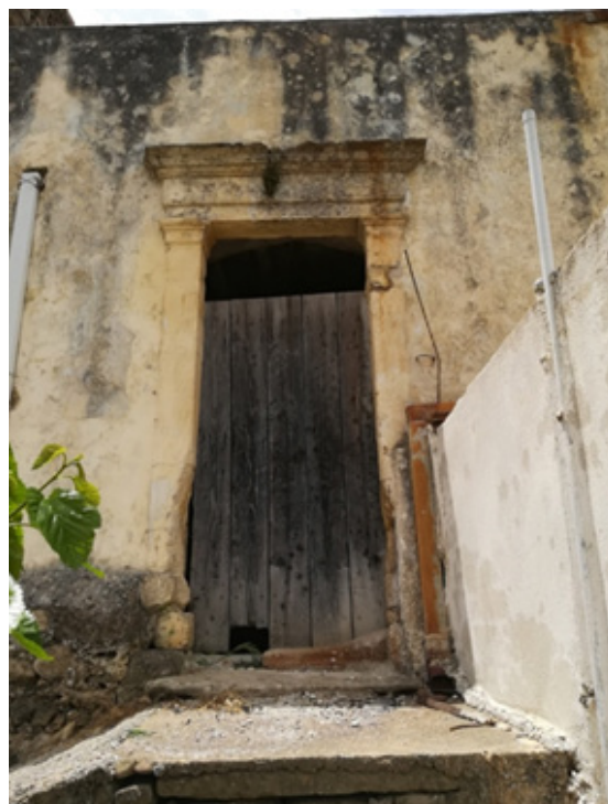
Εικ. 20. Η υπάρχουσα κατάσταση της δυτικής εξωτερικής πύλης-θύρωμα, μεταγενέστερη βενετσιάνικη κατασκευή.
